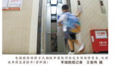
电梯维保师傅在电梯井中检查电梯设备,发现电梯故障原因(李梓博摄)
